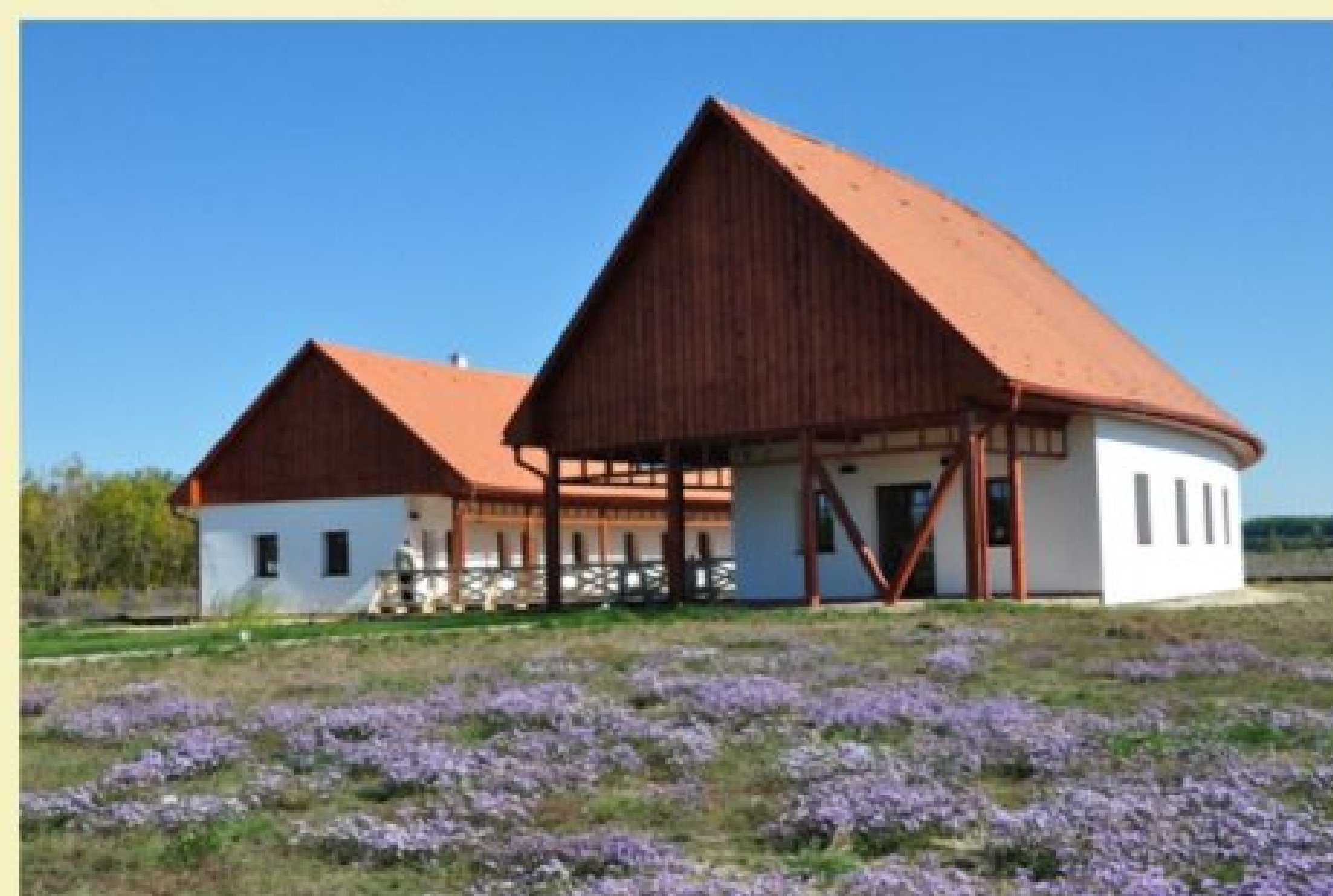
6. ábra - Épület látképe a parkoló felől
