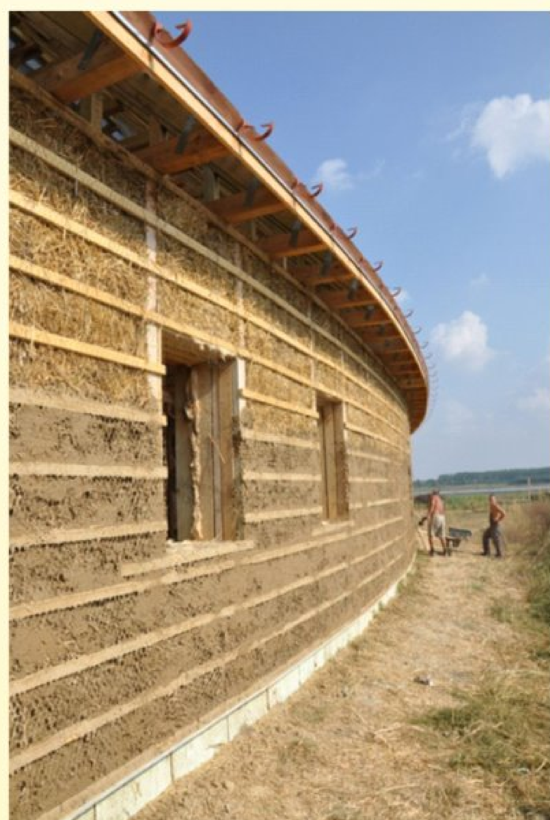
5. ábra - A szalmabálával szigetelt fal első vályogos gúzolásának felvitele a falazatra
